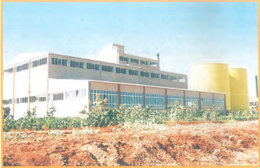
Şanlıurfa Organize Sanayi'de yapımı devam eden yağ fabrikası
