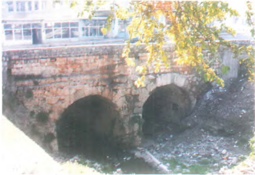
Resim 3 : Samsat Köprüsü, batı cephe
