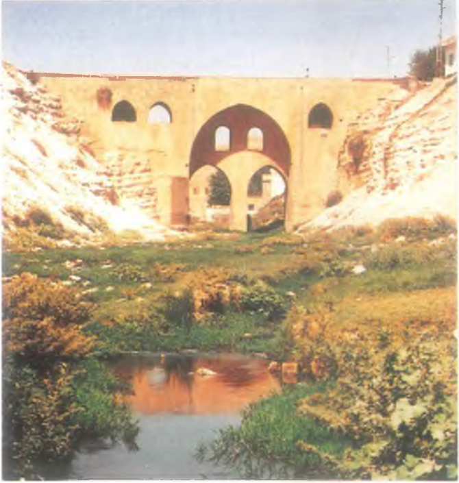
Resim 1 : Hızmalı Köprü, doğu cephe.
