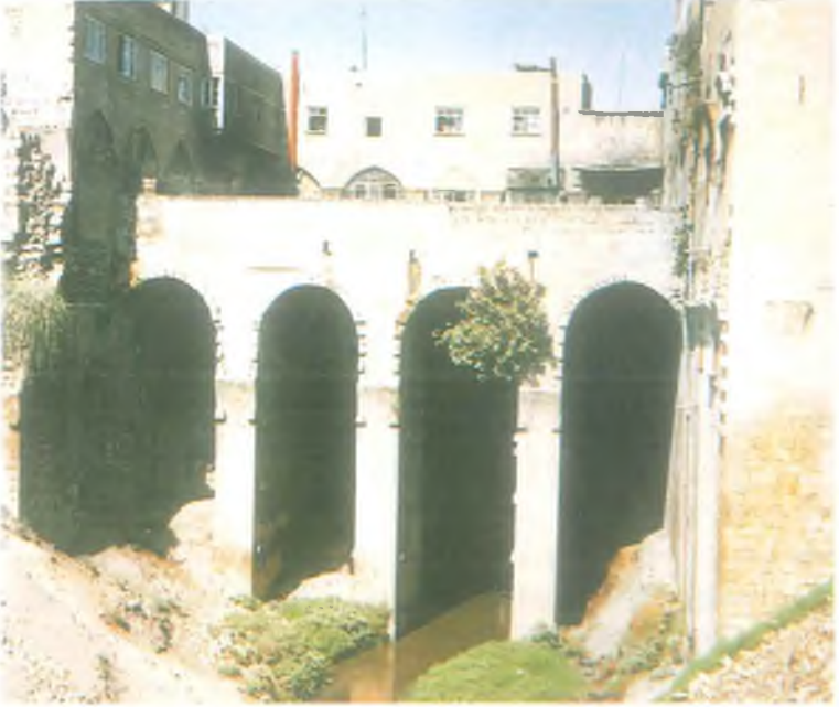
Resim 4 : Hacı Kâmil Köprüsü, doğu cephe.
