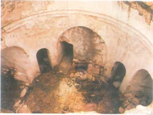
Resim 32 : Eski Arasa Hamamı Yıkama Hücrelerinden
