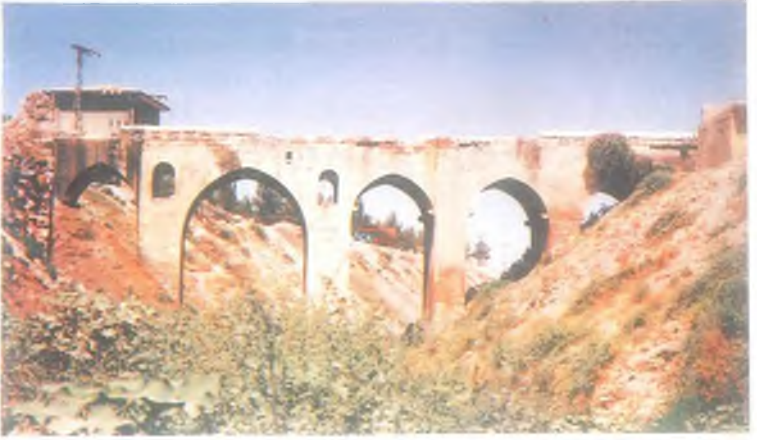
Resim 2 : Millet Köprüsü, doğu cephe.
