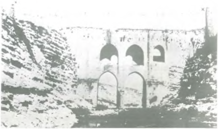
Resim 21 : Hızmalı Köprü Su Terazileri (x işaretli)
