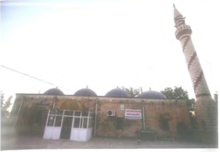
(50) Cabir El-Ensar Camii ve Türbesi
