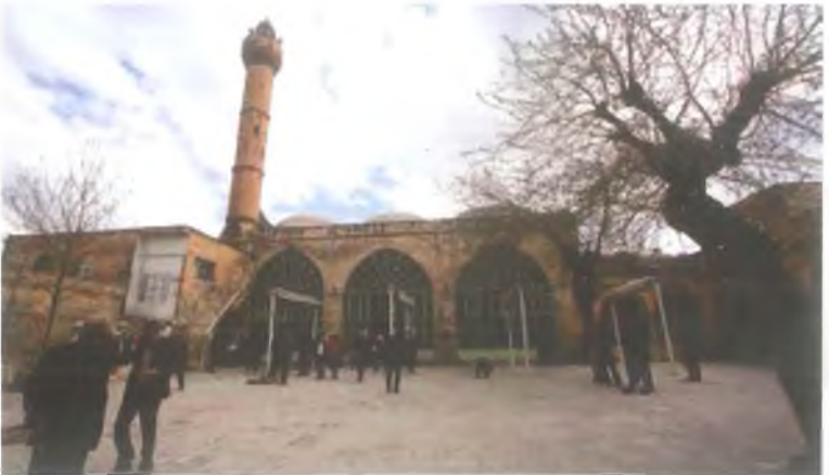
(24) Yusuf Paşa Camii
