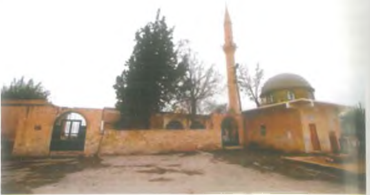
(247) İmam Bakır Camii
