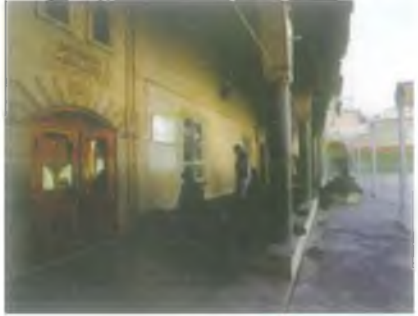
(24-a) Damat Süleyman Paşa Camii
