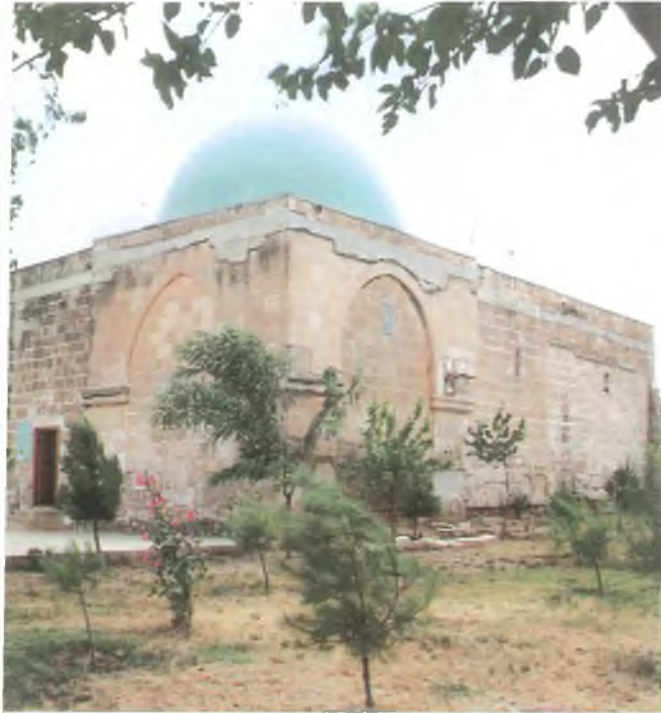
Picture 73. The Mausoleum of Hayat El-Harrani. Resim 73. Hayat El-Harrani Türbesi
