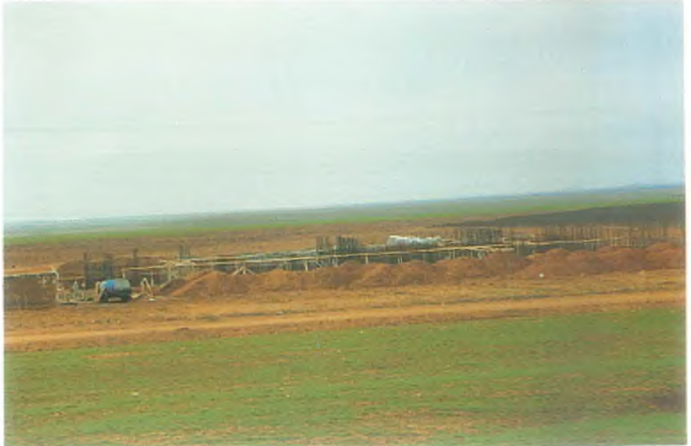
Merkeze bağlı Karaali Köyü'ndeki Kaplıca Tesisleri İnşaatı
