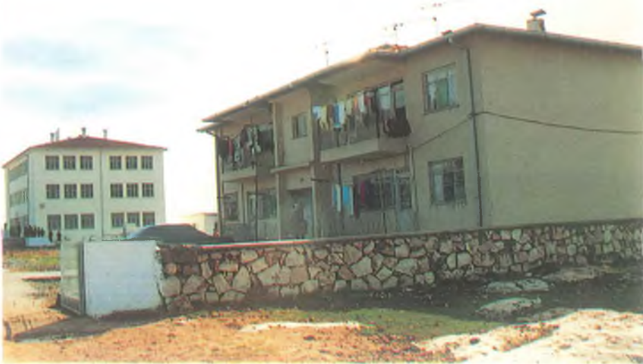
Argıl İlköğretim Okulu Lojmanları
