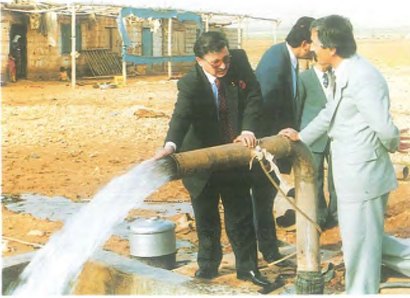
Karaali Köyü'ndeki Kaplıca Sondaj Kuyusu
