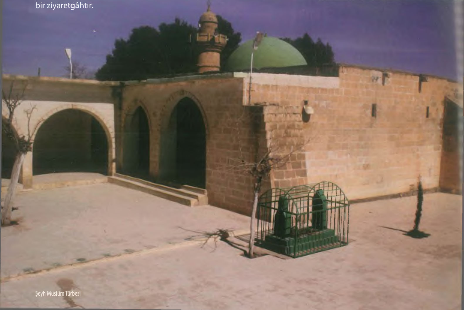
Şeyh Müslüm Türbesi İçten Görünüm
