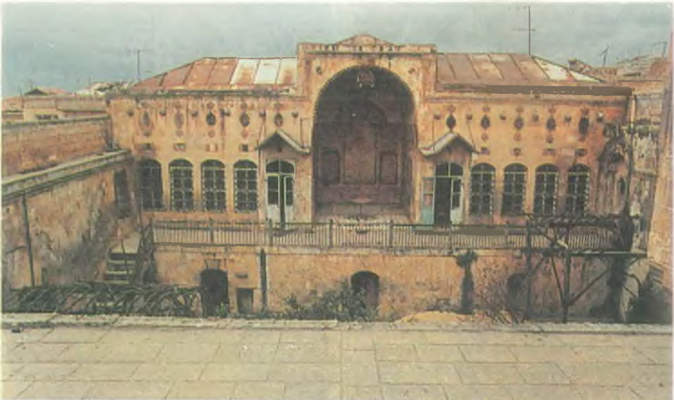
Hacı Bekir Pabuççu's House
