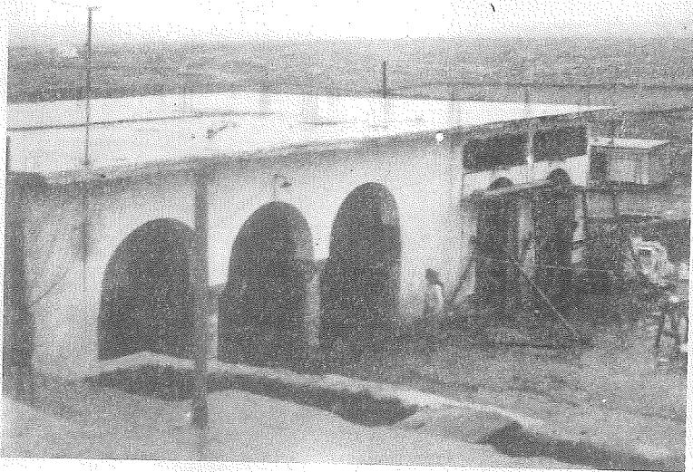
Eyyub Nebi Köyü Cami onarımı
