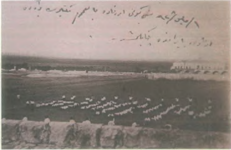
Askeriye (Hacı Kara Ağa) Hanı. Fotoğrafın sağında önde batı duvarı ve kemerleri görülen yapı. Gerisindeki yapı, Köy Yatı Mektebi/Eski Hükümet Konağı’dır. (Bugünkü İl Kültür ve Turizm Müdürlüğü). Fotoğrafın üzerine Osmanlıca, “1 Mayıs 928’inci günü Urfa’da bil’umum mekteplerin bir arada .....bayramında çekilmiştir” yazılmıştır.
