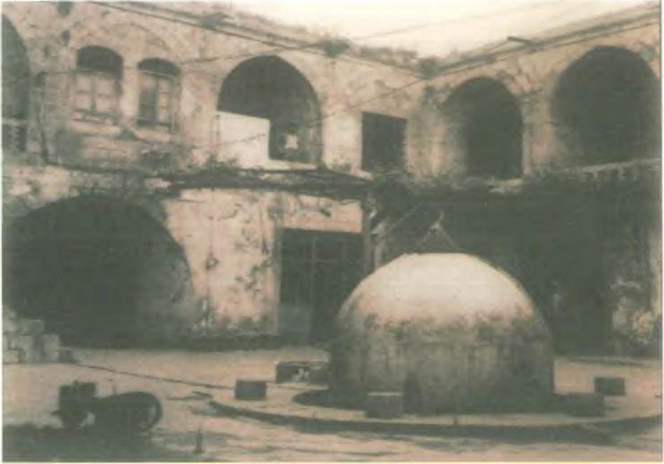
Hacı Kâmil Hanı. Avlunun güney-doğu köşesi restorasyon öncesi.
