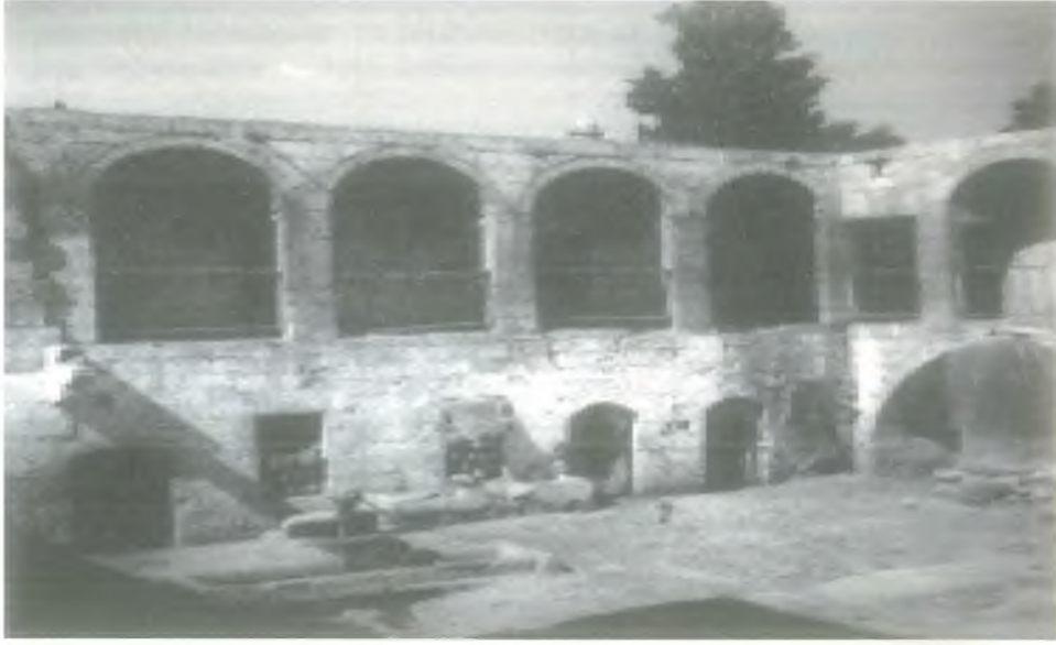
Şaban Hanı, avlunun kuzey-doğu köşesi (Yıkılmadan Önce).
