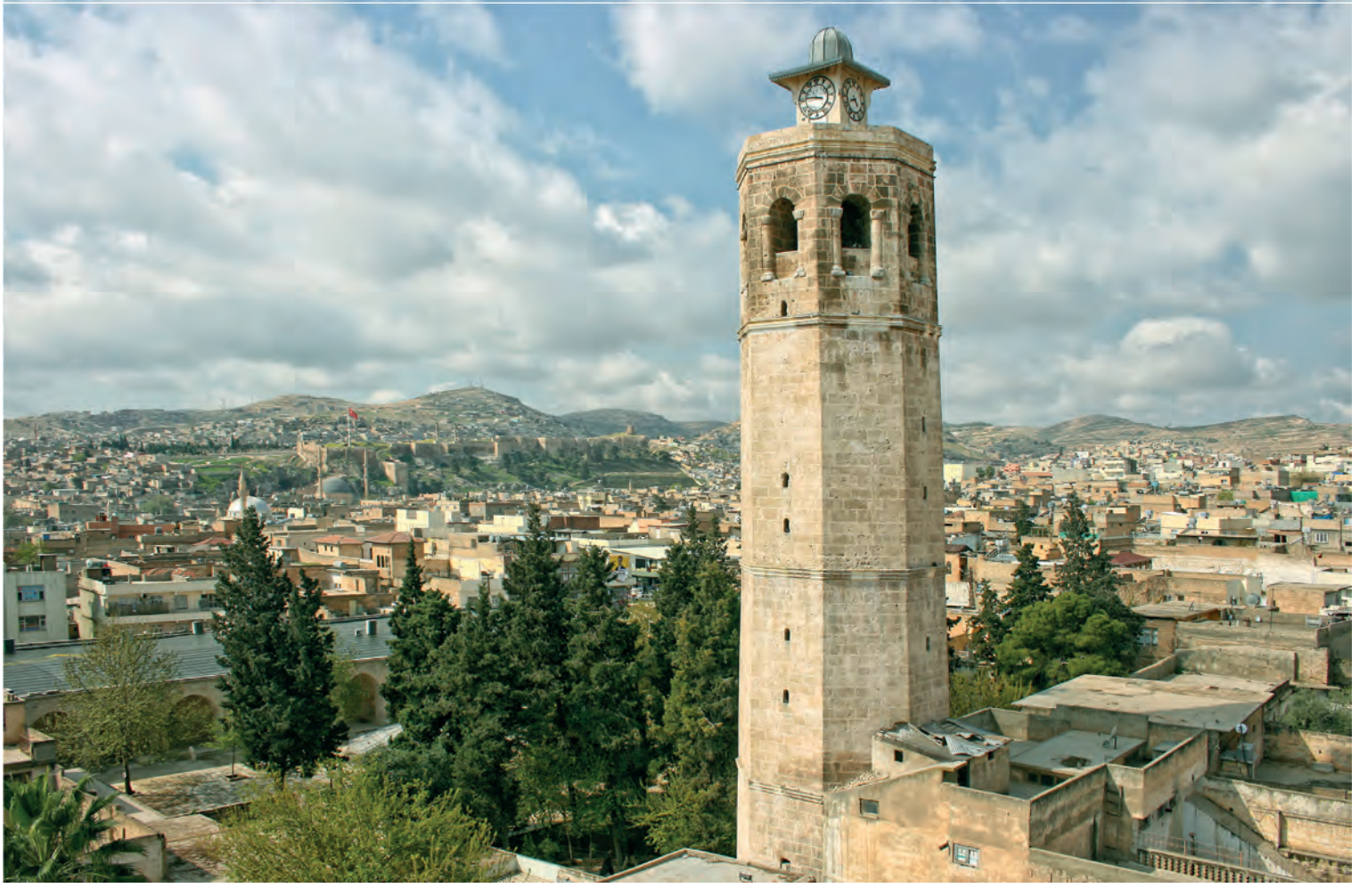
7) Urfa Ulu Camii ve Şehrin Güneybatısı-2011
