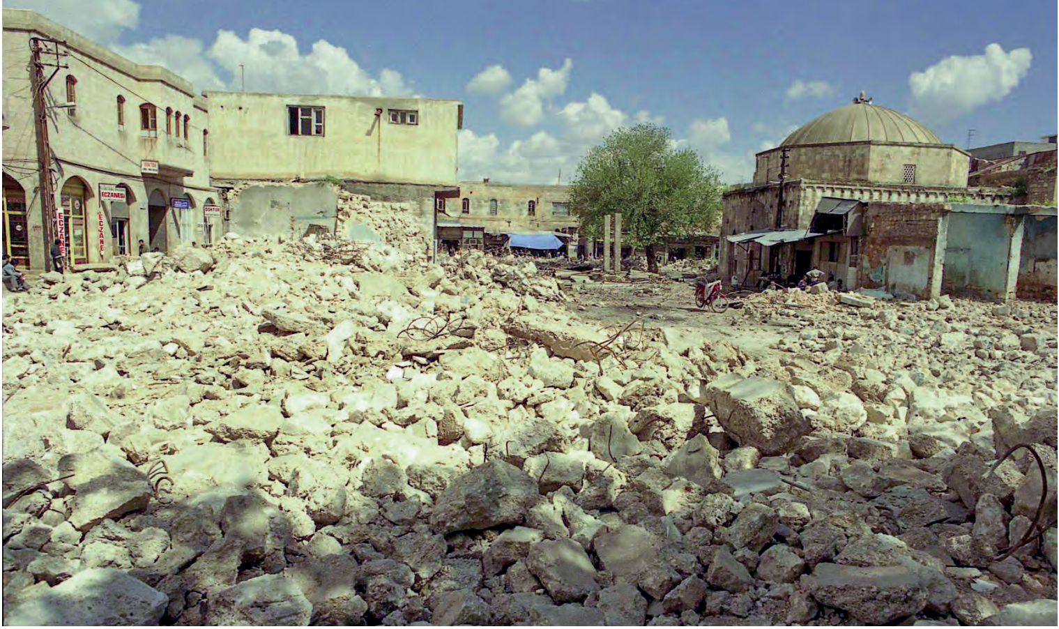
43) Eski Mevlevihâne Külliyesi'ndeki sebze hali ve dükkânların yıkımı-2002
