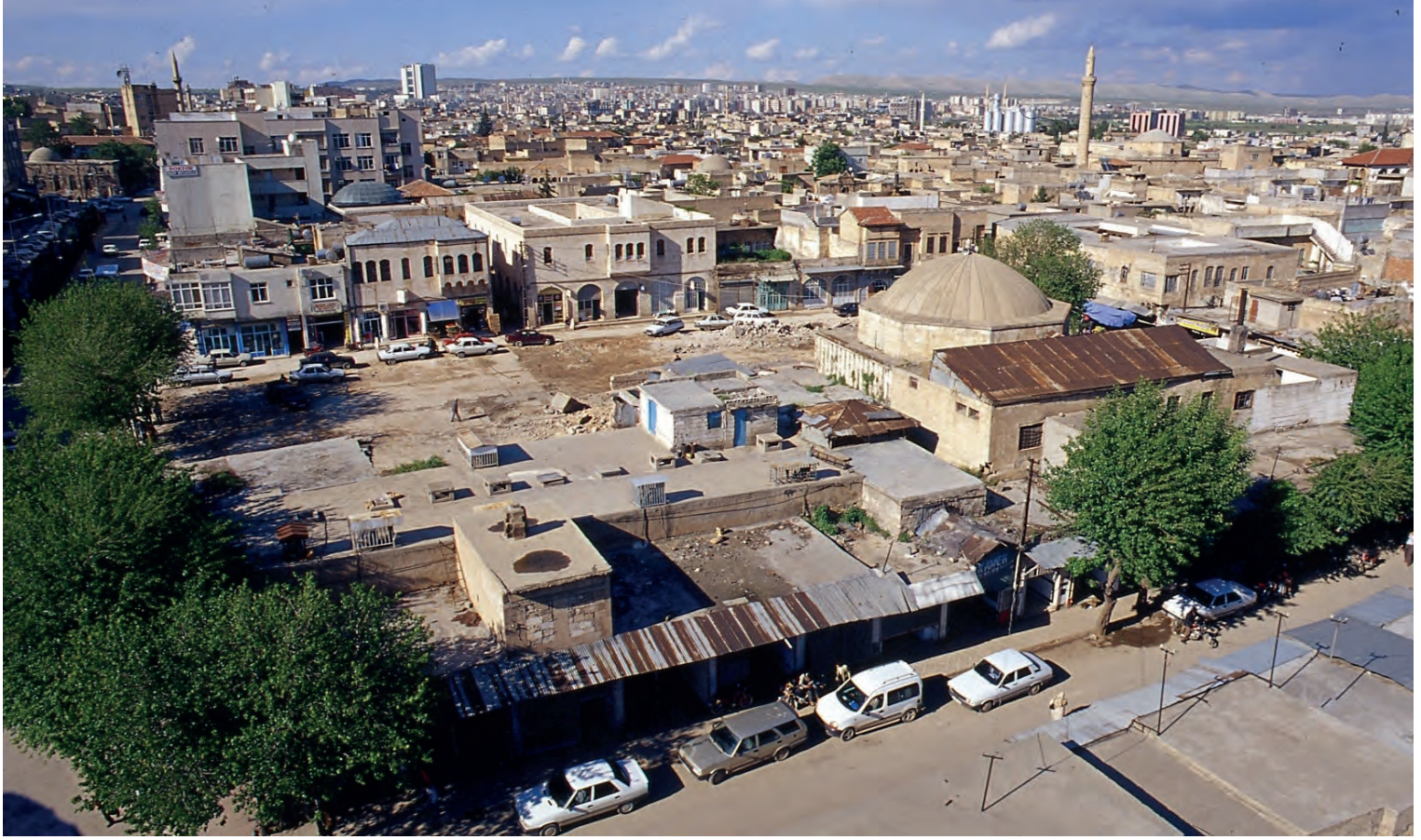
42) Eski Mevlevîhâne Külliyesi'nin çevre düzenlemesi için sebze halinin yıkılmaya başlanması-2002
