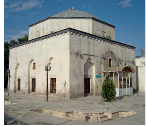
46) Mevlevihâne Camii (Eski Semâhâne) 2006 onarımı sonrası
